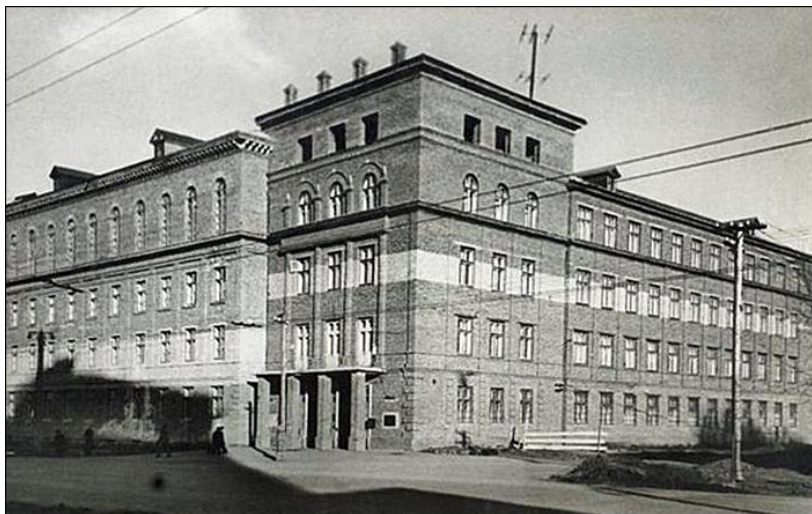
Первое здание Рязанского Радиотехнического института в 1952 году. Ул. Циолковского, 5. Основной корпус на ул. Большой (позже – ул. Гагарина) появится лишь через десять лет. Фото из частного архива.
