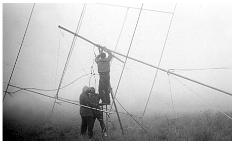
Монтаж антенны в традиционном на Полонине Руна тумане («Полевой день»), 2001 г.
