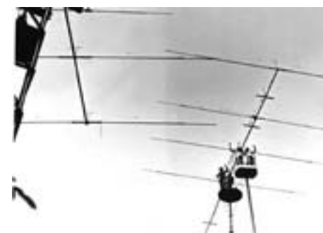
Ремонт антенны UK5MAF.
