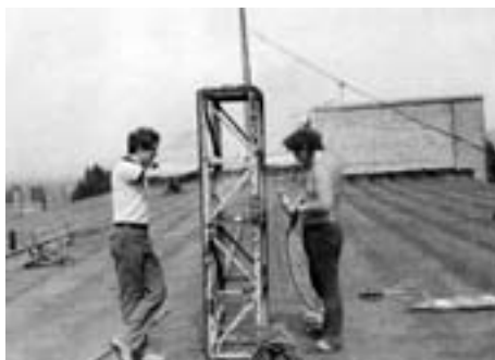
Монтаж антенны на крыше UB4MZL
