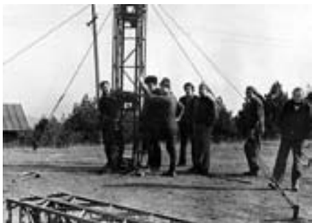
Установка 30-ти метровой разборной мачты конструкции «Унжа».
